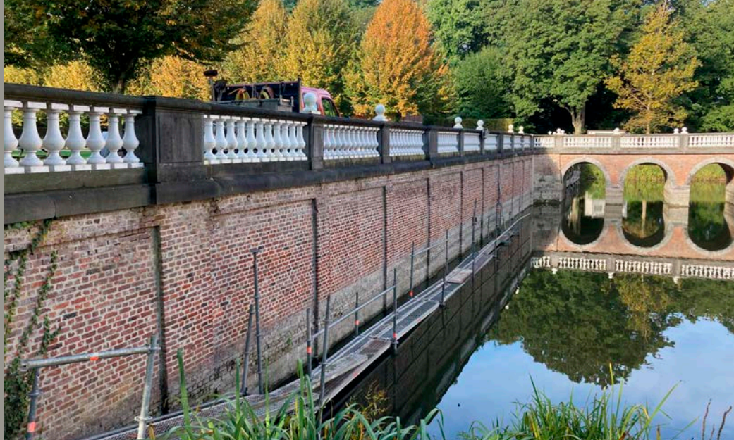
De keermuur en de brugpijlers krijgen een grondige onderhoudsbeurt
